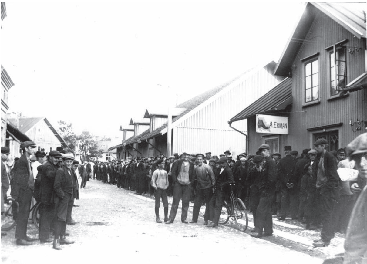
Kö utanför Mobergs tobaksaffär och A Ekmans skoaffär på Villagatan under första världskriget. Järnskog 3 syns på höger sida, med sina karakteristiska frontespiser mot gatan. Fasadpanelen är stående locklistpanel. Färgsättningen är ljus. Källa: Ingemar Karlssons donation, Tidaholms museums bildarkiv.
