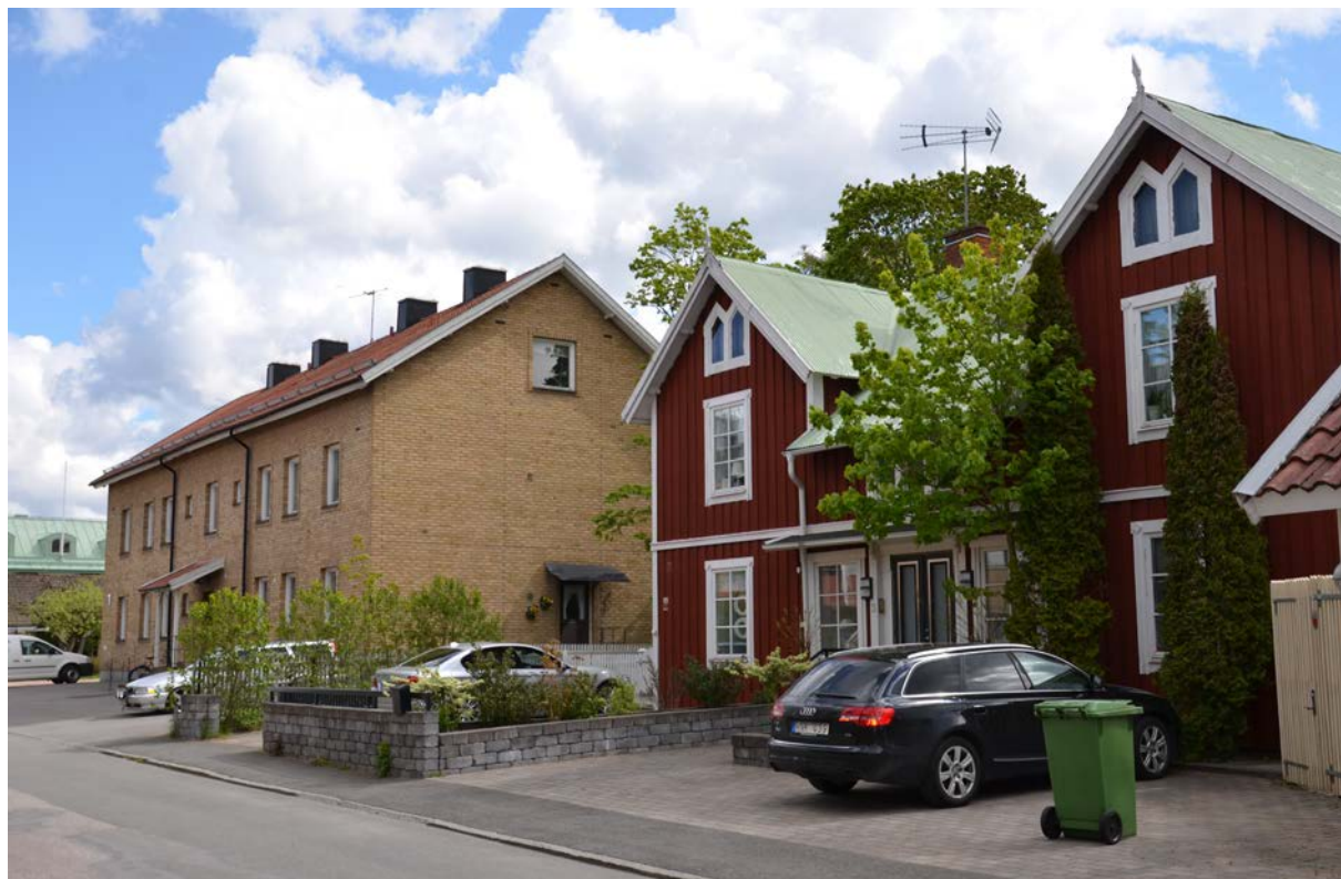
Kvarteret Järnskog utmed Fredsgatan. Närmast kameran Järnskog 5.
