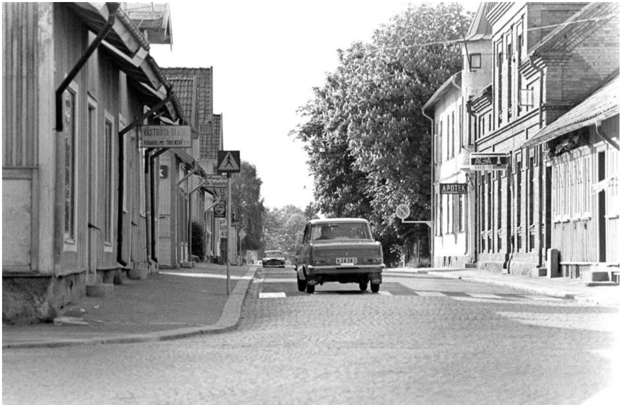
Villagatan på 1960-talet, sett från söder. Västgötabladets byggnad, närmast till vänster i bild, har kvar frontspiser mot gatan. Källa: Fotograf Ingvar Roth, Tidaholms museums bildarkiv.
