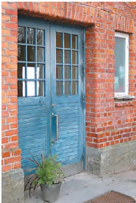
Nuvarande entrédörrar på norra fasaden. Foto 2012.
