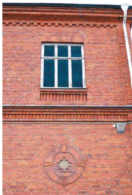
Till höger: Taklist, våningslist och mönstermurning i fasad mot öster. Blindfönster i övre våningen. Foto 2012.
