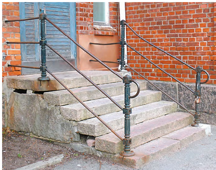
Räcke av smides- och gjutjärn på trappor av granit. Foto 2012.
