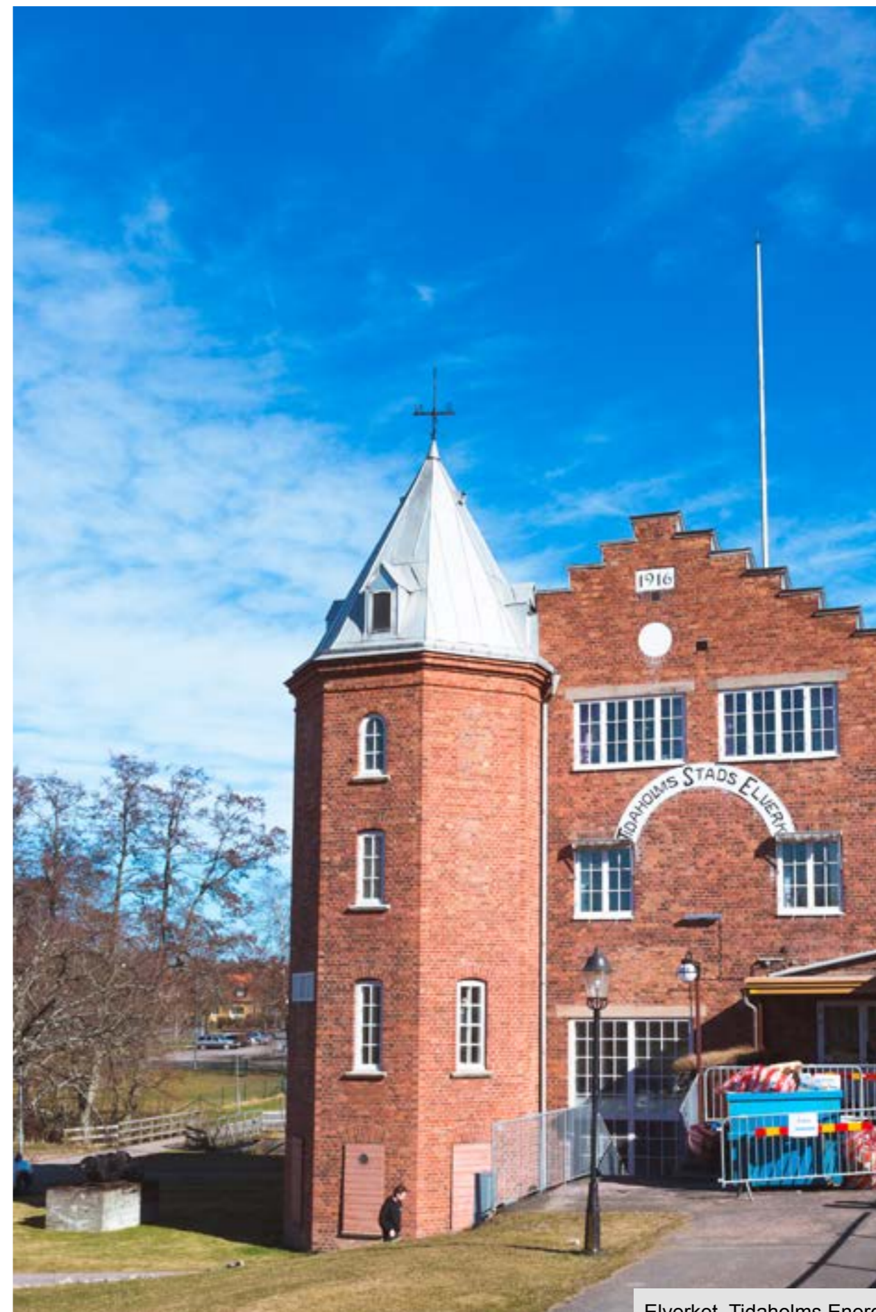
Elverket, Tidaholms Energi
