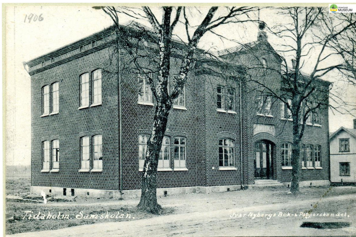
Den nyligen uppförda Samskolan. Enligt notering på fotografiet togs bilden 1906. Lägg märke till fönstrens utformning på andra våningens mittparti, som förändrades något vid 1930-talets ombyggnad. Tidaholms museums bildarkiv. Foto i Signe Lidwalls donation. Bildnr: 50050076752_e2f9ccf3bd
