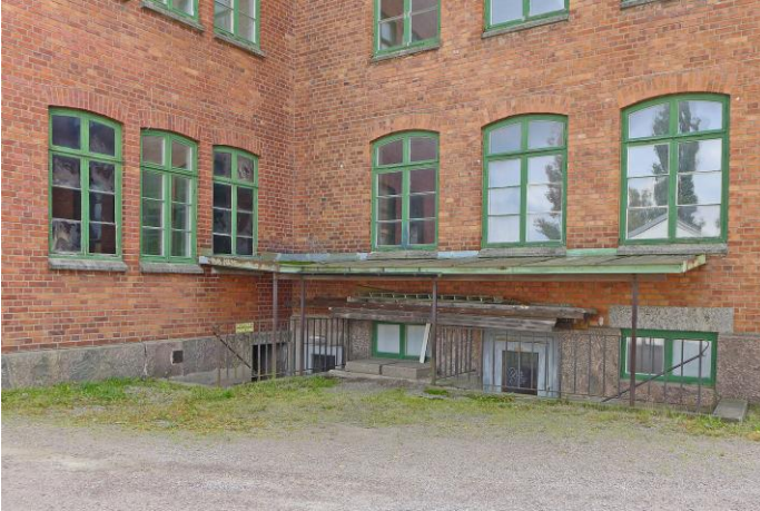
Vid källaringångarna till toaletterna vid norra fasaden syns skillnaden mellan de olika byggnadsdelarnas socklar tydligast.
