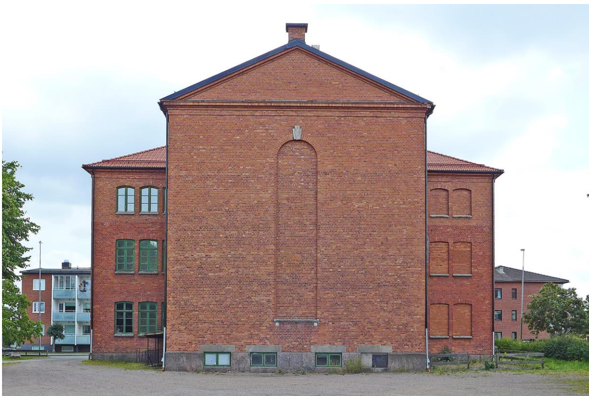
Fasaden mot skolgården i väster domineras av den klassicistiskt utformade nischen i murverket.
