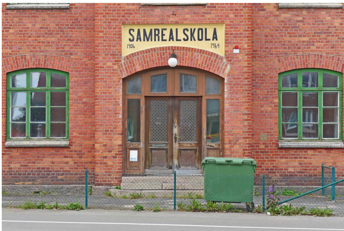
Huvudingången på fasaden mot Norra Kungsvägen har bevarat sin ursprungliga karaktär. Jämför med bilderna på sidorna 6 och 7.
