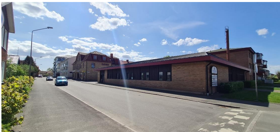
På fastigheten Örvang 10 i korsningen mellan Villagatan och Trädgårdsgatan ligger det s.k. Kontorshotellet som uppfördes 1978 i gult tegel och brun träpanel kring fönsterpartierna. Byggnaden är uppförd i en våning med valmat svart plåttak.
