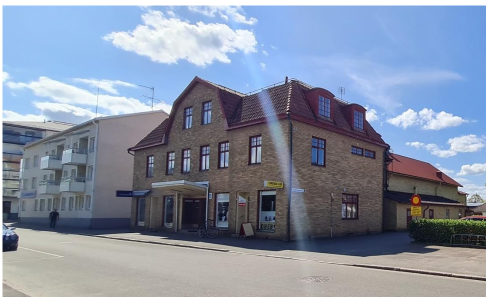
Den vita putsade byggnaden på Örvang 9 syns till vänster i bild och till höger på Örvang 4 syns en gul tegelbyggnad med nybyggnadsår 1929. I denna byggnad har biografen "Röda Kvarn" funnits. Byggnaden planeras att rivras.
