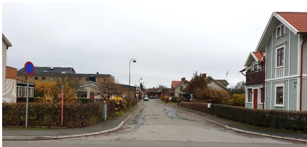
Korsningen Trädgårdsgatan/Vasagatan med godsmagasinen i slutet av gatan. Planområdet syns till vänster i bild och utpekad värdefull byggnad närmast fotografen till höger i bild.
