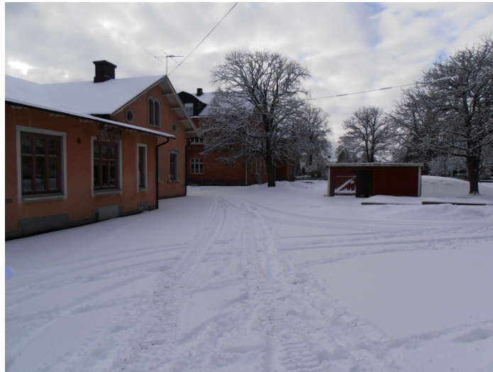
● Äldre skolbyggnader som skall bevaras
