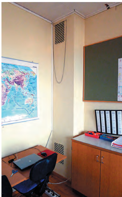
Ursprunglig ventilationskanal med gjutjärnsgaller i sal mot gården, 1 tr.
