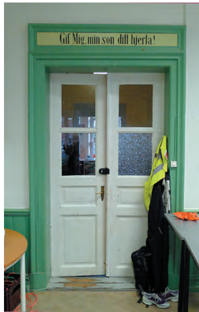
Halvfransk glasad pardörr med överstycke och devis i skolsal i NV.
