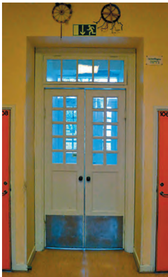
Halvfranska svängdörrar till vindfång mot gatan. Foto 2012.
