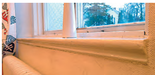
Ovan: De flesta fönster bevarar fönsterbänk med profilerad framkant.
