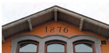
Profilerade sparrändar och byggnadsåret.
