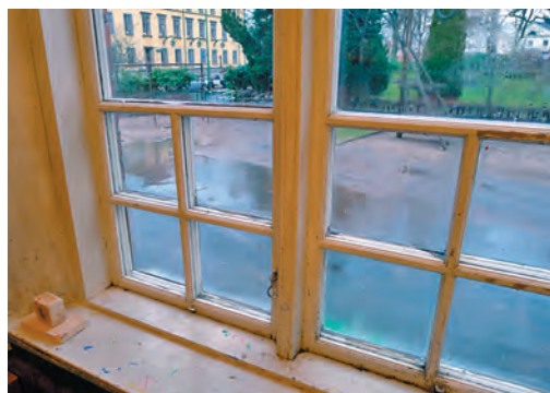
Äldre fönster på gavlarna med spröjsad nederdel.
