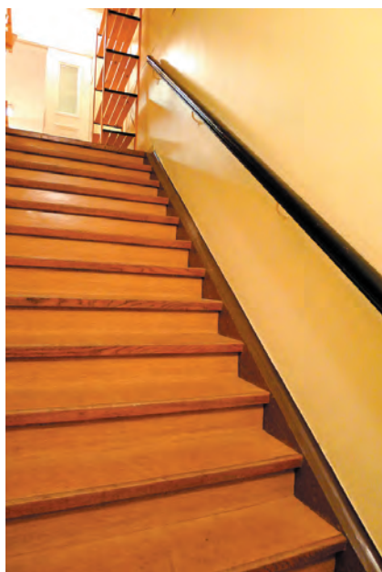
Trappa mellan bottenvån. och övre vån. mittparti.
