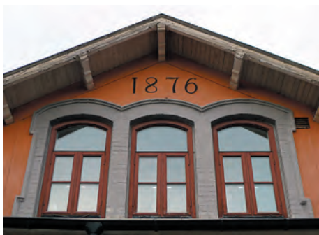
Gamla skolan bär fortfarande byggnadsåret i frontespisen. Foto jan. 2012.
