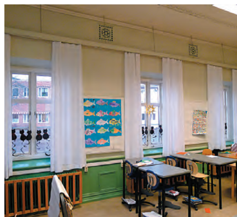
Gjutjärnsgaller till den ursprungliga ventilationen. Hur uppvärmningen skett är oklart, men möjligen har rummen uppvärmts av järnkaminer.
