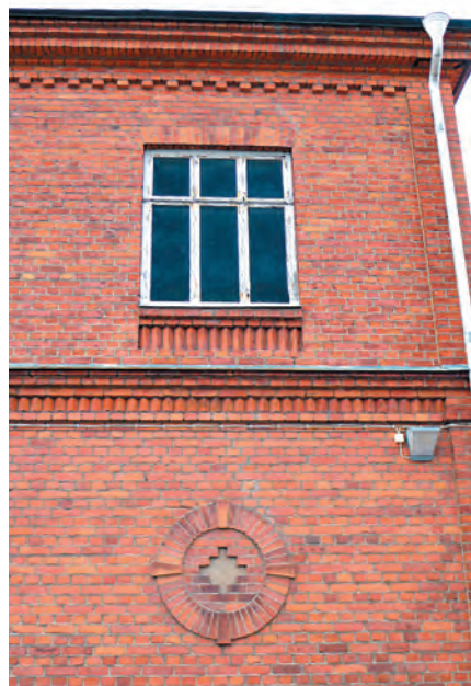
Taklist, våningslist och mönstermur- ning i fasad mot öster. I övre våning- en ett äldre blindfönster. Foto 2012.
