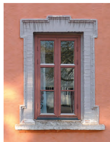
Ursprunglig fönsteromfattning av formtegel på fasaden mot norr/skolgården. Foto 2012.
