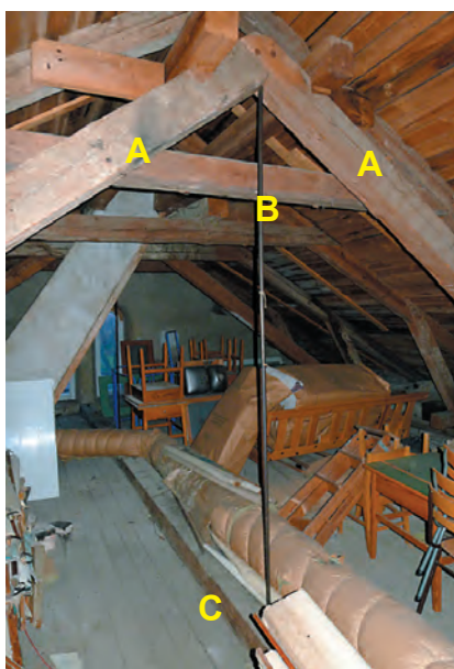
Västra vinden sedd mot söder med upphängning av bjälklaget.
