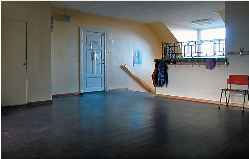
Ursprungligt golv med gjutmassa i östra trapphusets övre plan.
