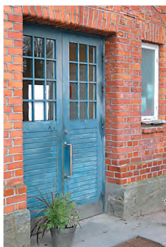
Nuvarande entrédörrar på norra fasaden. Foto 2012.
