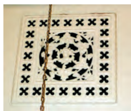
Gjutjärnsgaller till den ursprungliga ventilationen. Hur uppvärmningen skett är oklart, men möjligen har rummen uppvärmts av järnkaminer.
