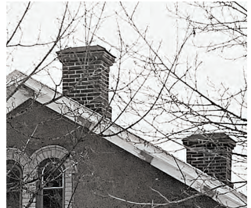
Skorstenarna på foto från ca 1900. Idag är de inklädda med plåt.
