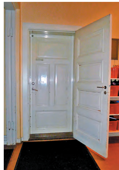
Halvfranska enkeldörrar i förstuga bv mot materialrum. Högra dörren troligen sekundär.
