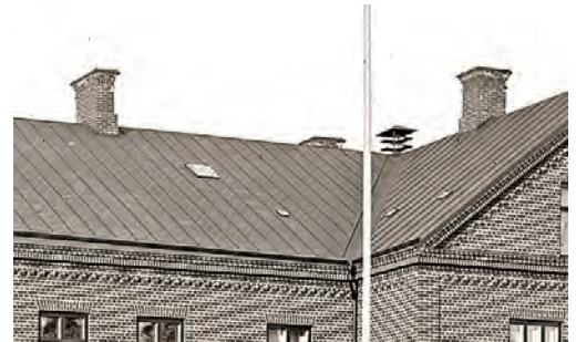
Tegelskorstenar, plåttak och vattenföring på foto från 1890-talet. Idag är skorstenarna inklädda med plåt.
