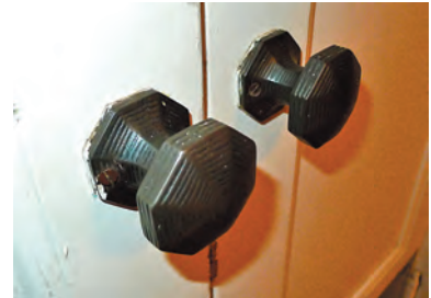
Dörrtrycken till vindfångens svängdörrar.
