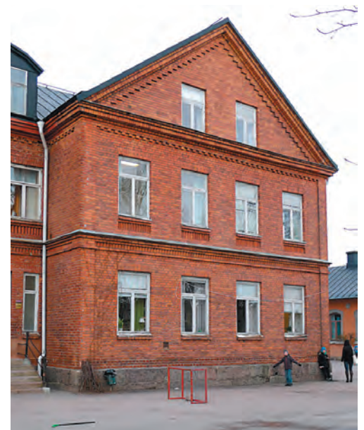
Nya Skolan, östra flygelns fasad mot söder. Foto 2012. Jämför mellanvåningens fönstersättning med den gamla bilden ovan.
