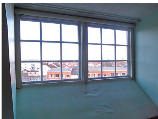
Spröjsade fönster i vindsvåningen, mittpartiet.
