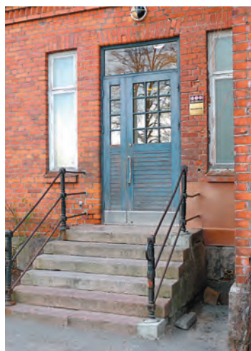
Nuvarande entrédörrar på södra fasaden. Foto 2012.
