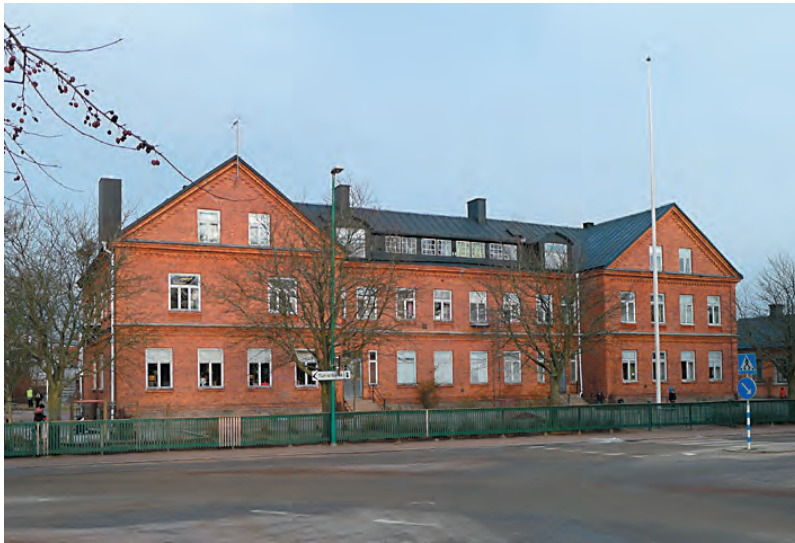
Nya Skolan, fasad mot Östra Drottningvägen. Foto 2012.
