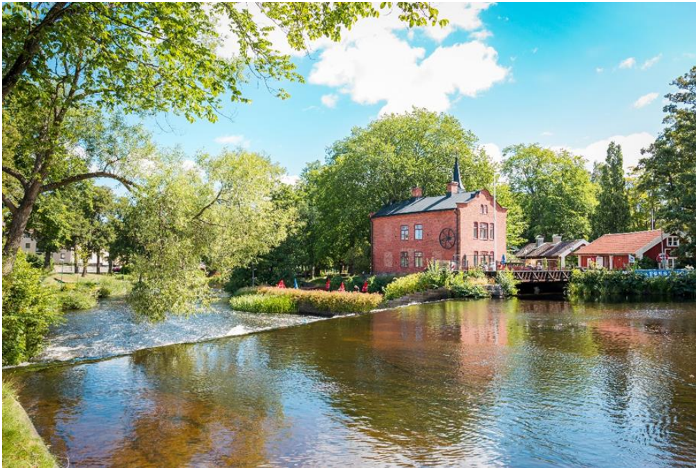
Bild på Turbinhusön i Tidaholm.
